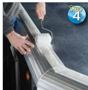
**Pressare** il nastro con un rullo morbido per conformarlo ai bordi delle giunzioni o altri elementi sporgenti.
