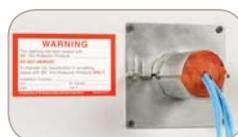
L'installazione di stucco e l'applicazione di una etichetta di identificazione completano il lavoro. Lo stucco tiene i cavi in posizione, aiutando a prevenire lo slittamento ed il movimento del cavo stesso.
