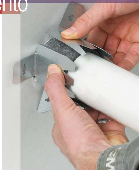
*Le strisce avvolgibili 3M Fire Barrier Tuck-In sono ideali per l'utilizzo con tubi in plastica PVC, PVCC, PE e PP per l'attraversamento di pavimenti e solette in cemento, muri in mattoni e blocchi di cemento, pareti in cartongesso.*
